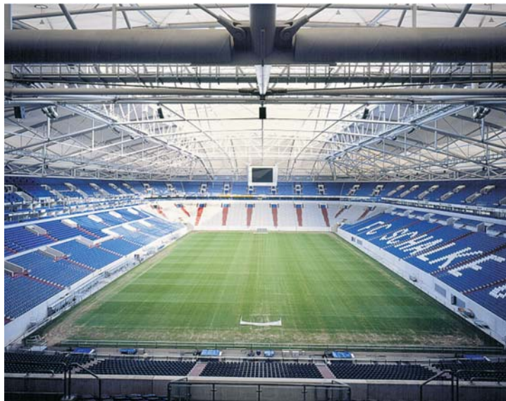
STADION DER SUPERLATIVE: Das 5.000 Tonnen schwere Fachwerk-Dach sorgt AufSchalke für einladend helle Atmosphäre.
